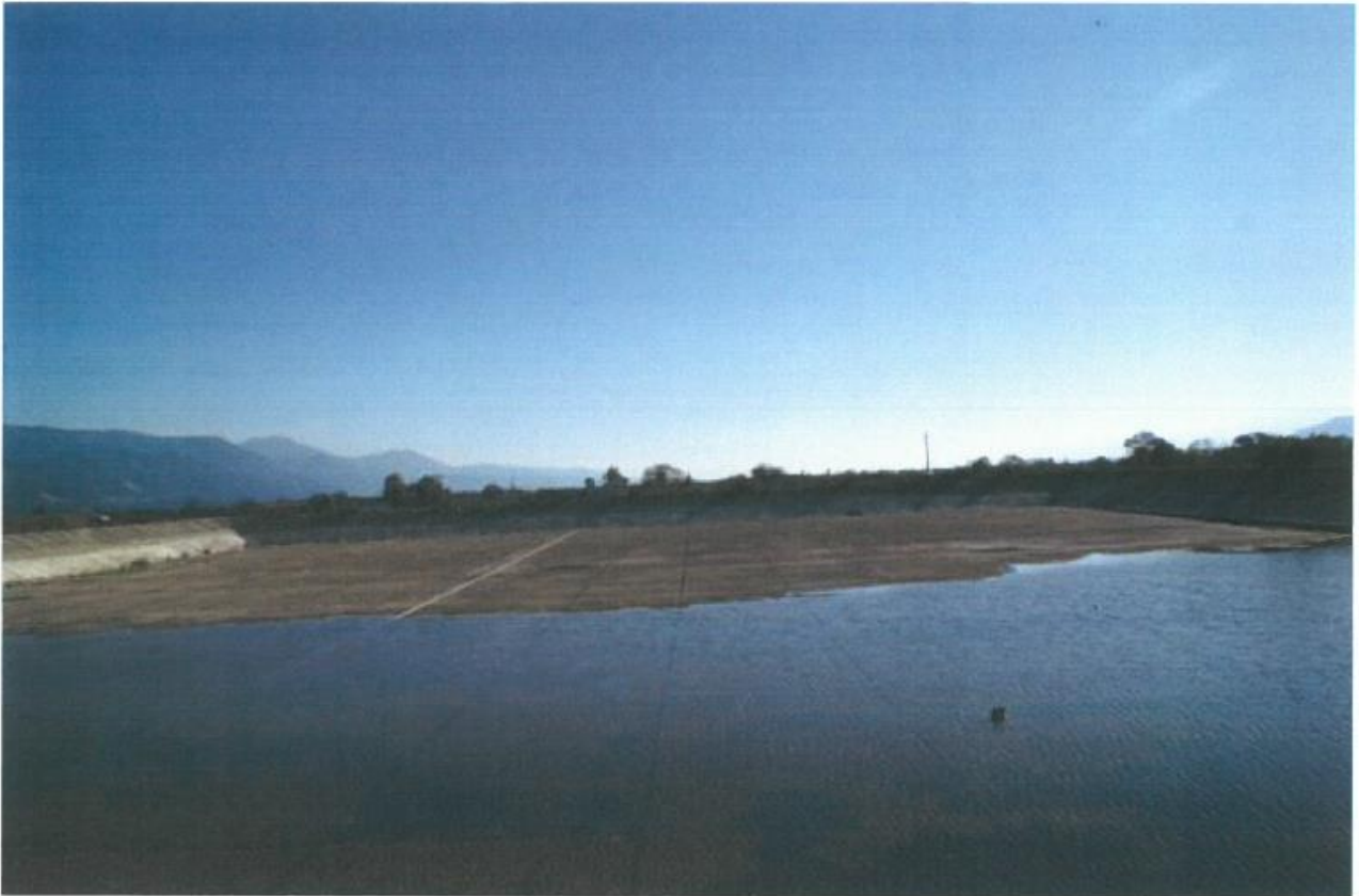
Εικ. 1 Κεντρική Δεξαμενή (εσωτερικό)
