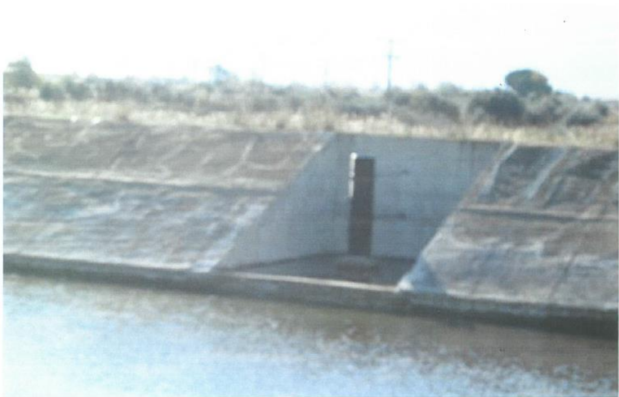
Εικ. 3 Κεντρική Δεξαμενή –Υπερχείλιση (εσωτερικό)
