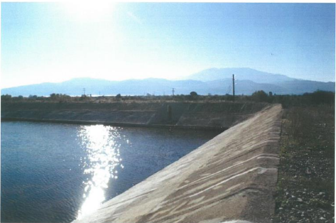
Εικ. 2 Κεντρική Δεξαμενή (εσωτερική παρειά)
