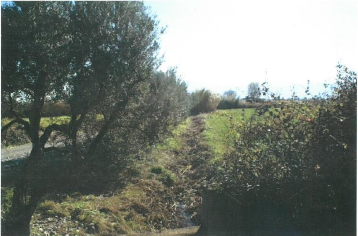
Εικ. 27 Διώρυγα Δ2-θέση αντλιοστασίου 5
