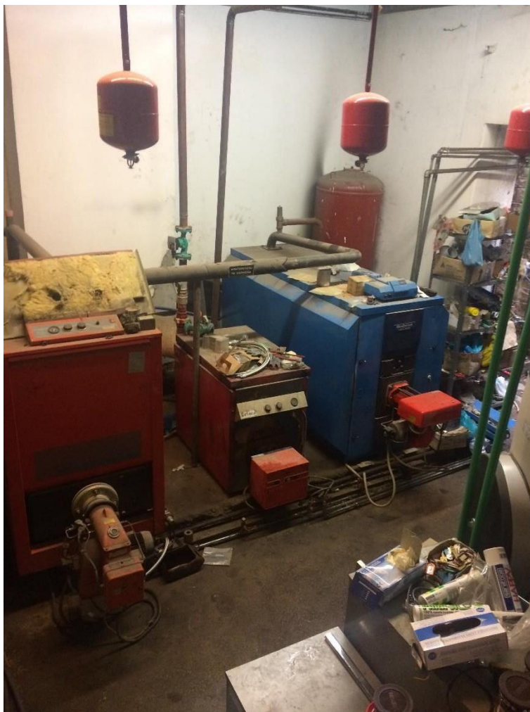
Εικόνα 3.1.1.: Λέβητες παλαιού κτιρίου
