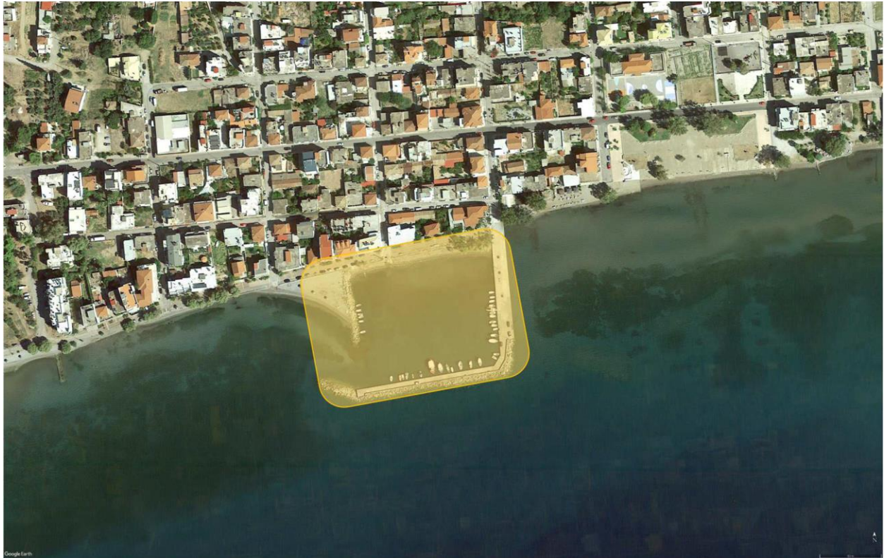
Εικόνα 1.2: Υφιστάμενες λιμενικές εγκαταστάσεις - Κίρρα
