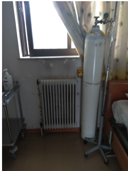
Εικ. 2 Αποσάθρωση εσωτερικών επιχρισμάτων λόγω υγρασιών (2)
