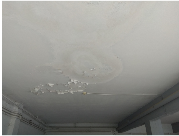
Εικ. 1 Αποσάθρωση εξωτερικών επιχρισμάτων λόγω υγρασιών
