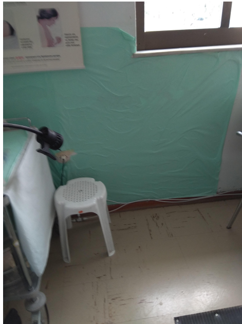
Εικ. 2 Αποσάθρωση εσωτερικών επιχρισμάτων λόγω υγρασιών (2)
