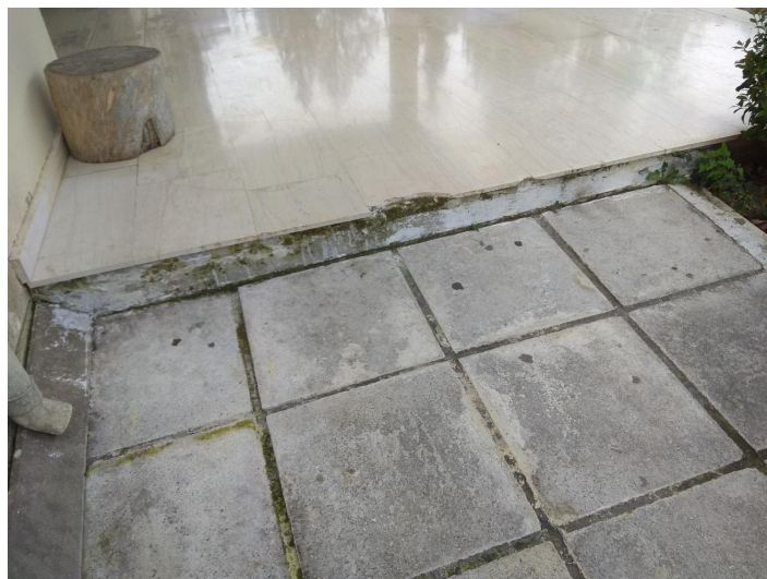
Εικ. 6: Απουσία ράμπας στα αριστερά της κυρίας εισόδου για πρόσβαση ΑΜΕΑ
