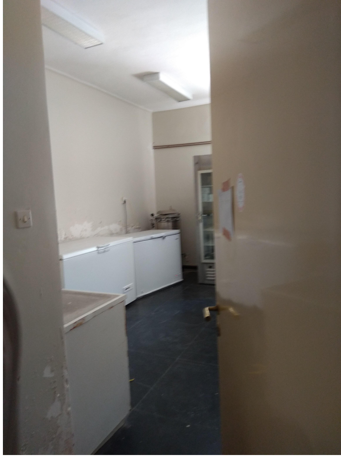
Εικ.7 Το κτίριο χρειάζεται βάψιμο εσωτερικά και γενική συντήρηση
