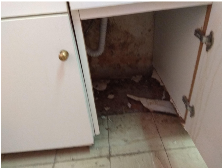
Εικ.8: Εσωτερικές υγρασίες από διαρροές των σωληνώσεων
