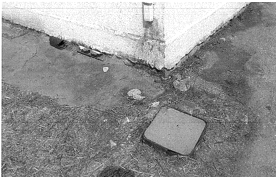
Εικ. 20 Αντικατάσταση φρεατίου.
