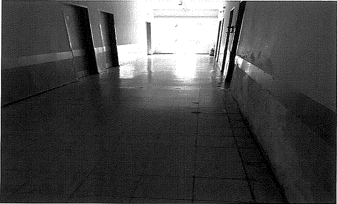
Εικ. 8,9 Αντικατάσταση της επένδυσης των δαπέδων.
