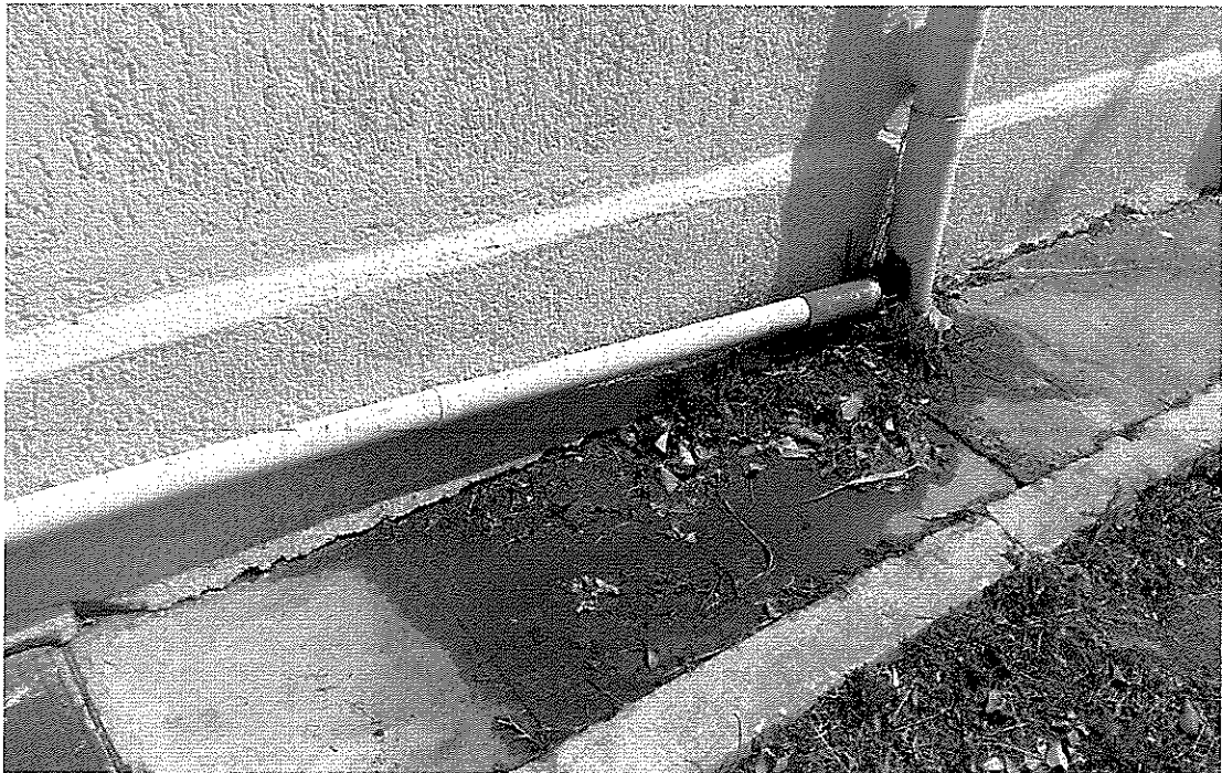
Εικ. 10 Αντικατάσταση σωλήνων αποχέτευσης.
