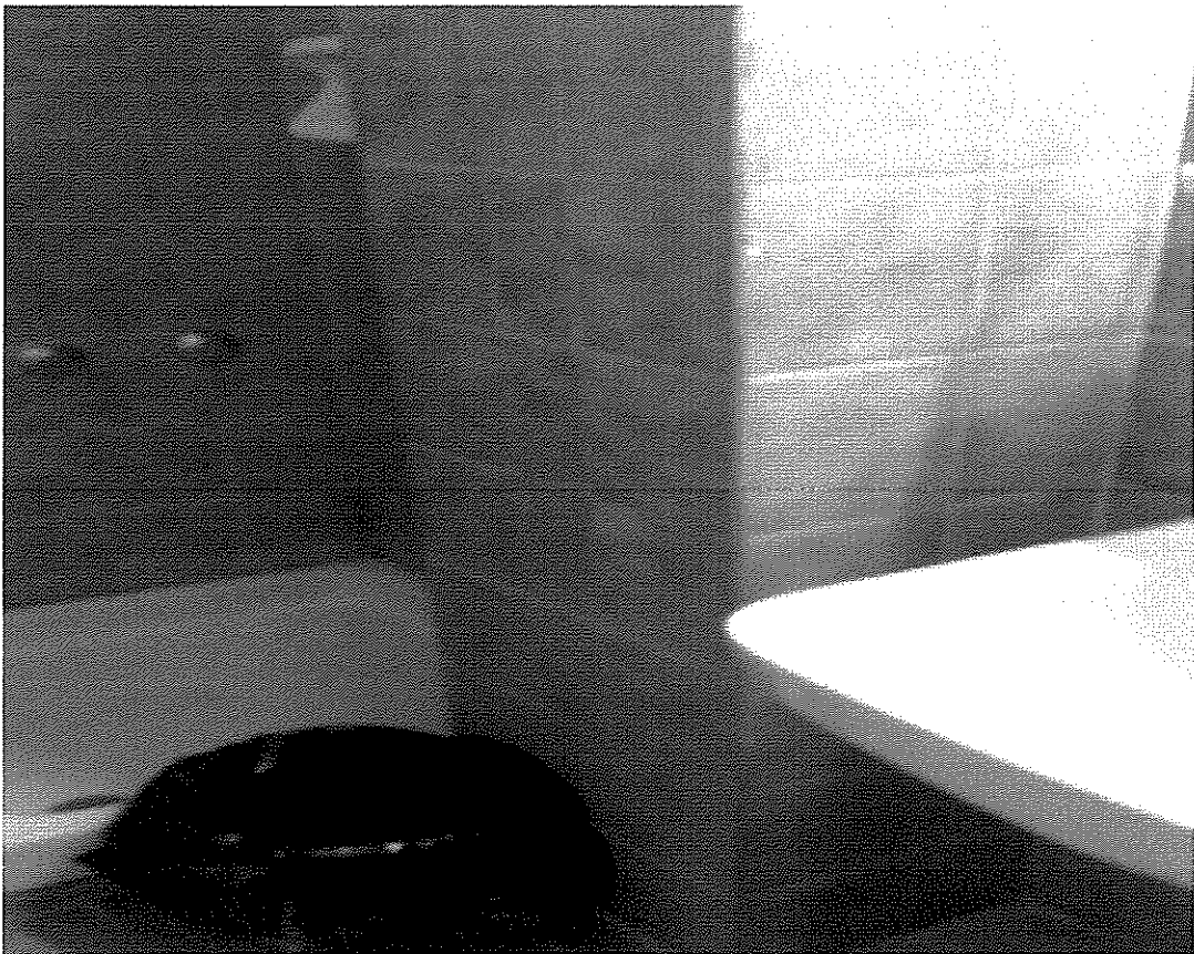
Εικ. 11,12 Αντικατάσταση πλακιδίων-ειδών υγιεινής W.C.
