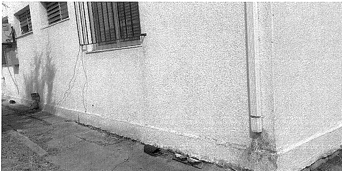
Εικ. 18,19 Αντικατάσταση φθαρμένων υδρορροών.
