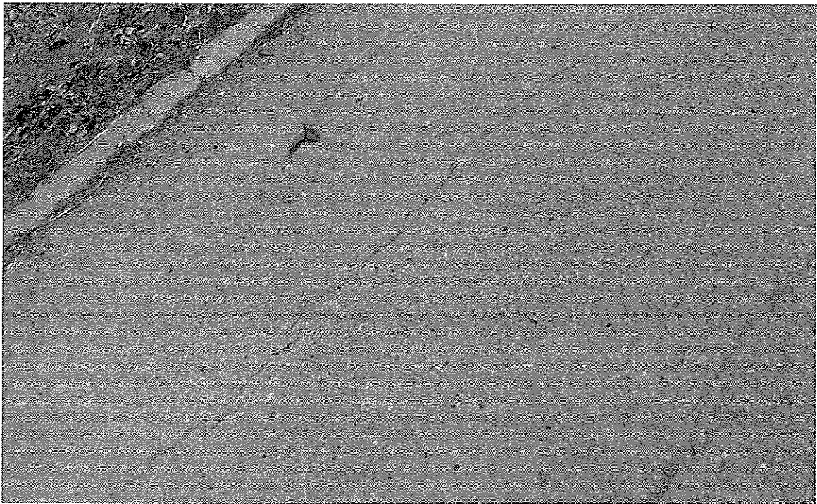
Εικ. 25 Αποκατάσταση ασφαλτικού τάπητα.
