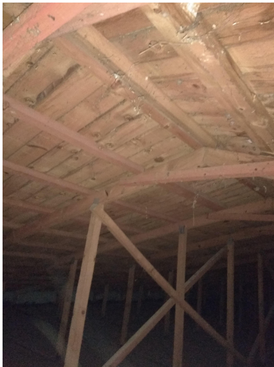
Εικόνα 3: Φθαρμένα ξύλινα στοιχεία στέγης
