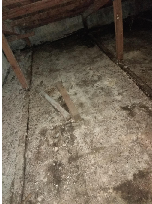
Εικόνα 5: Απουσία θερμομόνωσης οροφής
