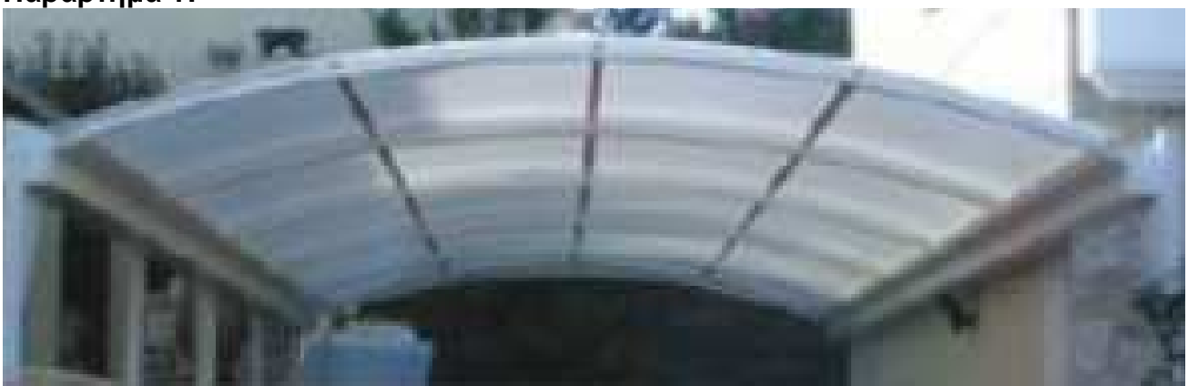
Φωτογραφία 14, Ενδεικτική μορφή ελαφριάς κάλυψης προς βιοκλιματική αναβάθμιση αιθρίου Πρωτοδικείου Αμφισσας
