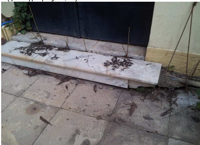
Φωτογραφία 12-13, Άποψη των καθιζήσεων του δαπέδου στο αίθριο του Πρωτοδικείου Αμφισσας
